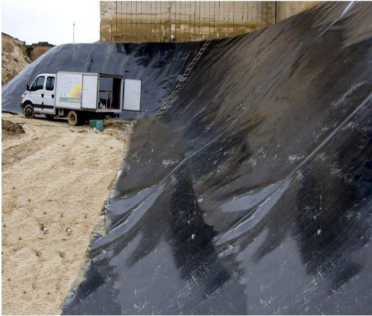
Fig. 5 Impermeabilizzazione delle pareti – Lotto 4. Fig. 6 Bacino di fondo allestito per lo scarico dei rifiuti – Lotto 3.
