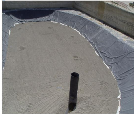
Fig. 5 Impermeabilizzazione delle pareti – Lotto 4. Fig. 6 Bacino di fondo allestito per lo scarico dei rifiuti – Lotto 3.
