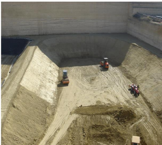
Fig. 3 Fasi di allestimento del fondo della discarica – Lotto 3.
