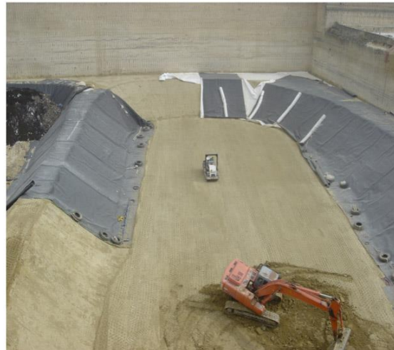
Fig. 4 Fasi di allestimento del fondo della discarica – Lotto 3.
